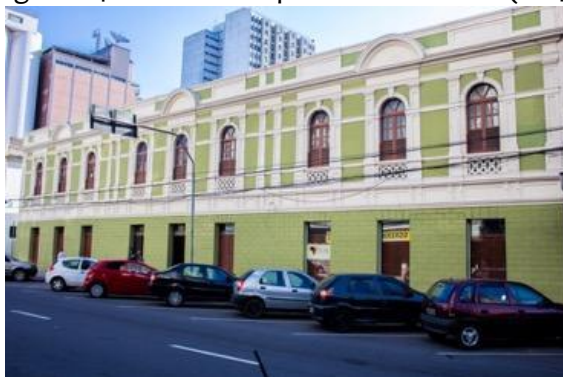
Figura 04 - Fachada do prédio do Mucane (2017)
