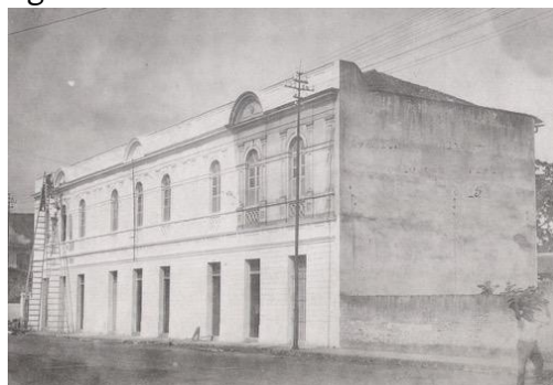
Figura 01 - Fachada do início do século XX
