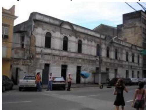
Figura 03 - Fachada do prédio do Mucane (2006)
