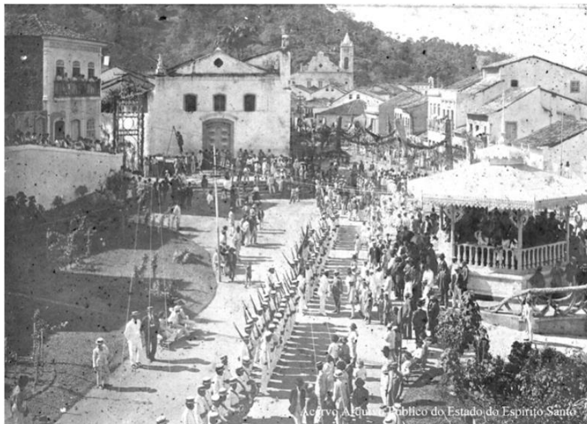
Figura 01 - Igreja da Misericórdia antes da demolição, 1911
